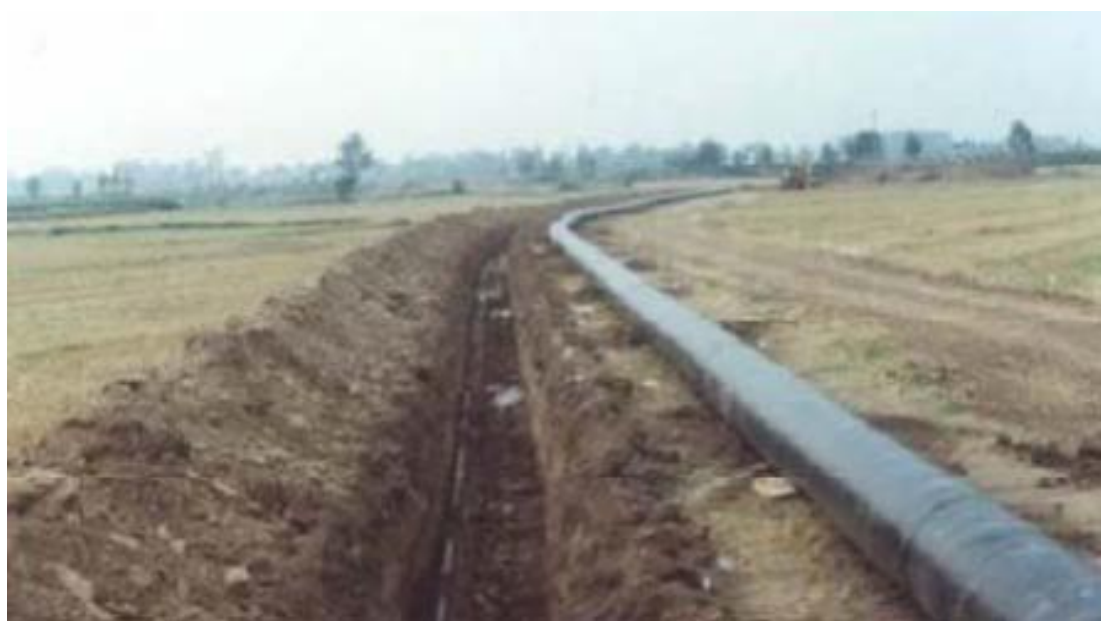
图 3.2-7. 国内同类工程管线开挖实景图片
