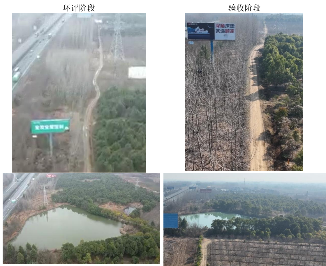
图 6.2-1. 施工前后基本农田保护区地貌对比航拍图
