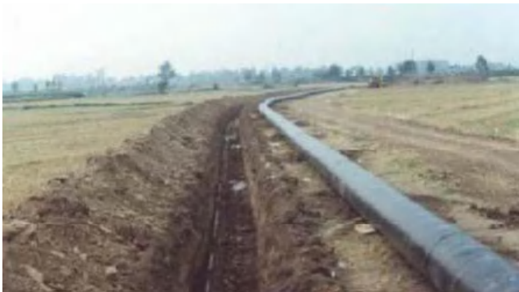
图 3.2.1-14 国内同类工程管线开挖实景图片
